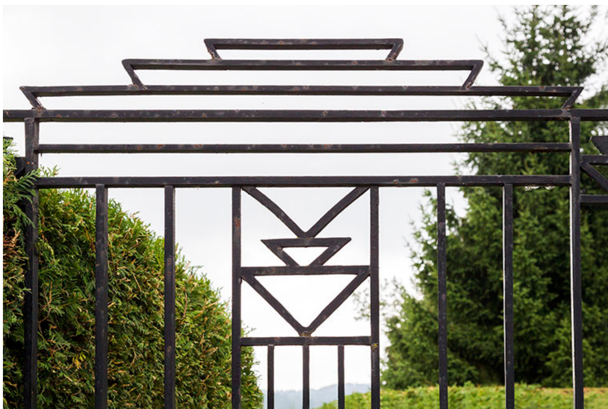
Grille près de l'atelier de 1930 (détail).
