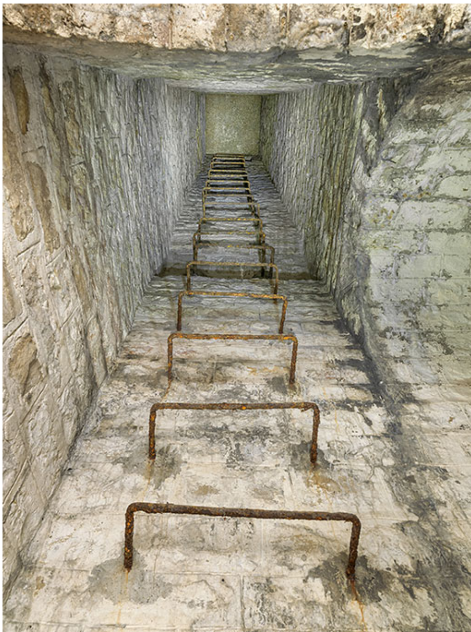
Echelle métallique d'un puits d'aération et de lumière.
