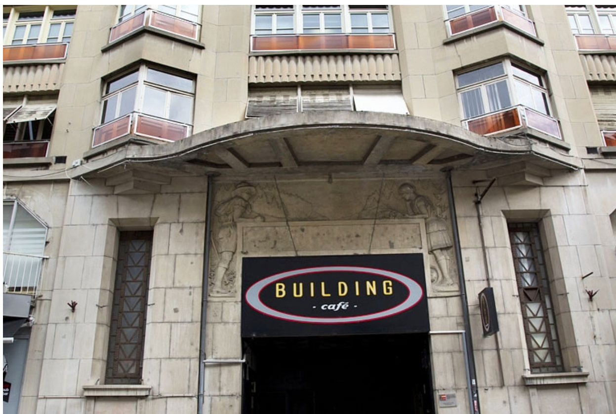
Détail de l'entrée, de face.
