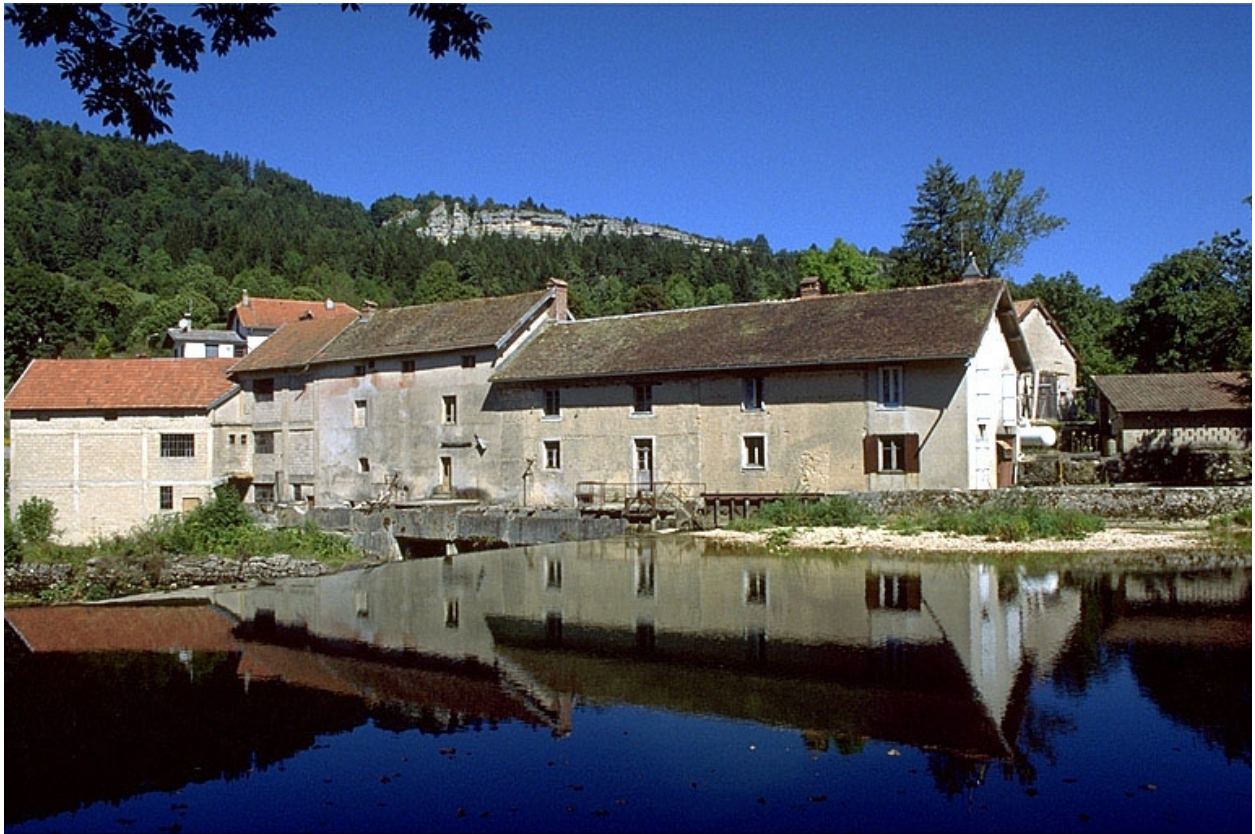
Façades sur rivière. De gauche à droite : magasin industriel, atelier de fabrication et logement ouvrier.
