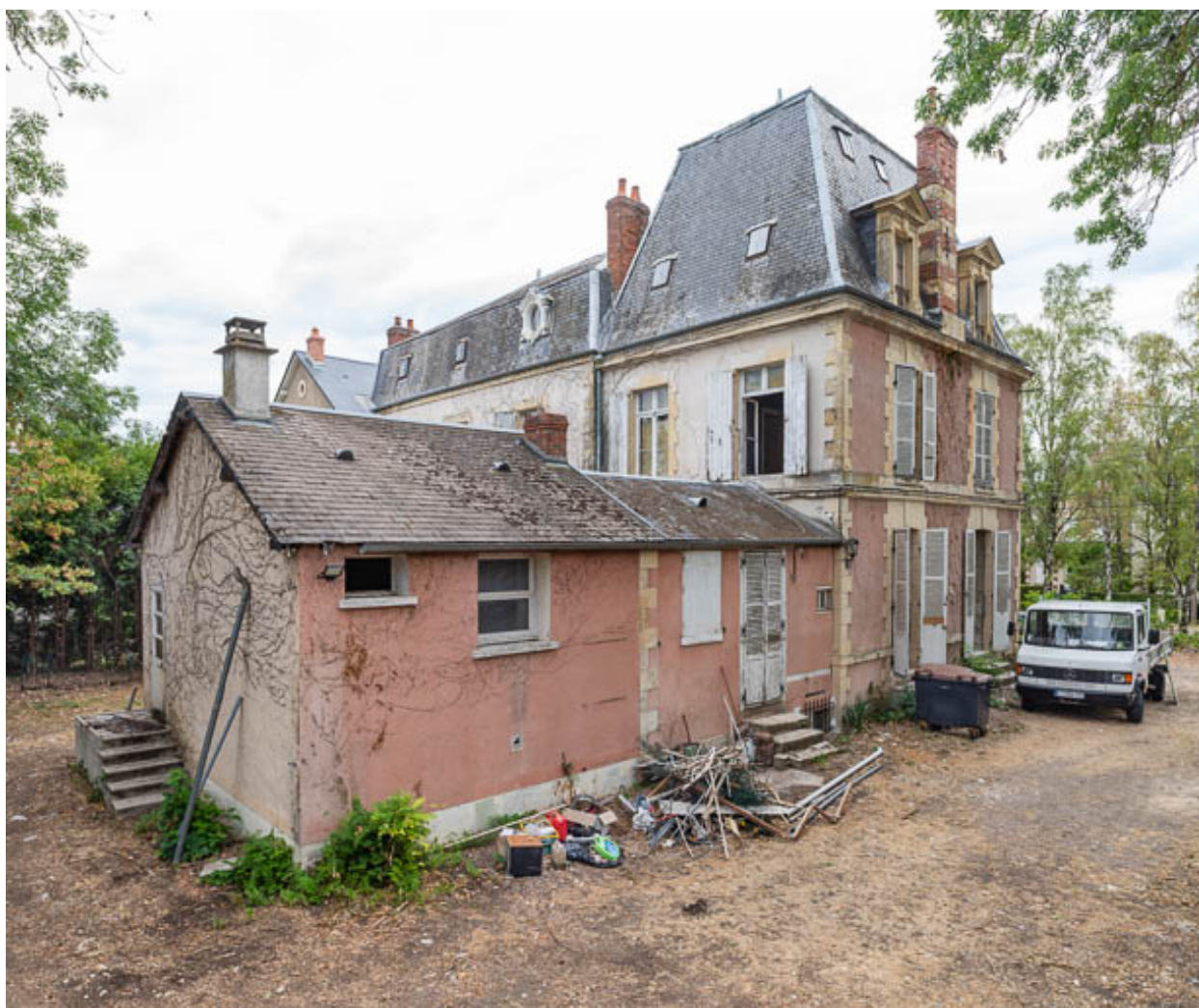
Extension à l'arrière du pavillon sud.
