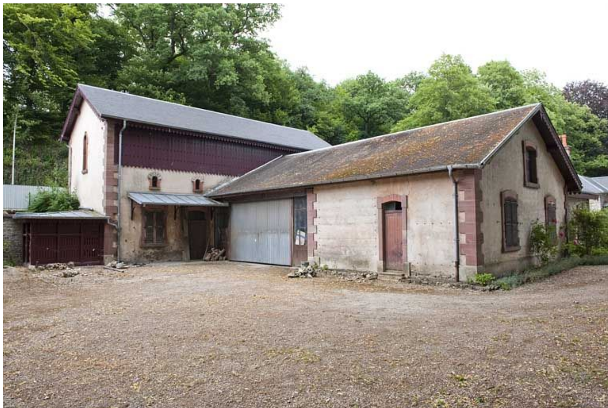
Communs vus depuis le nord-ouest.
