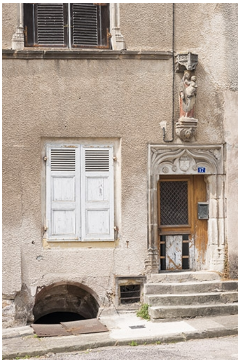
Façade antérieure : détail du rez-de-chaussée.
