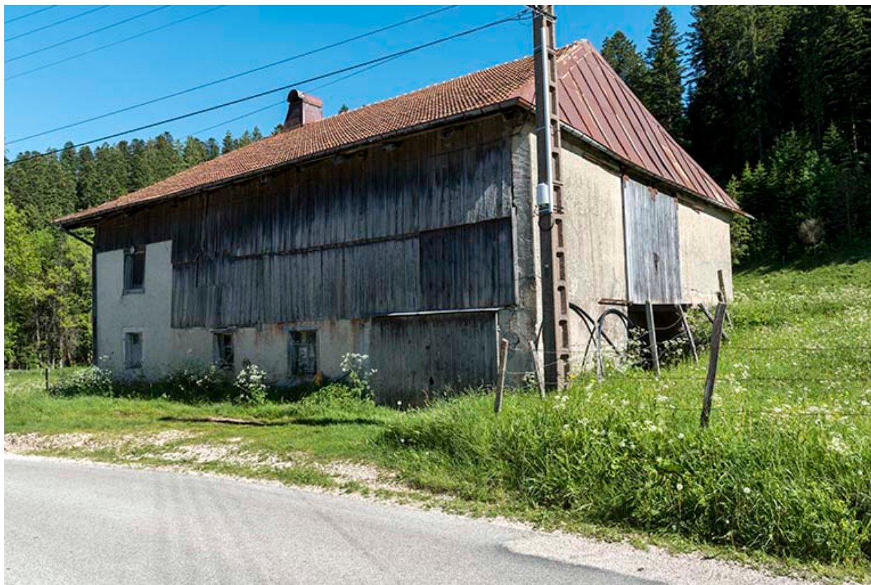
Façades nord et ouest.
