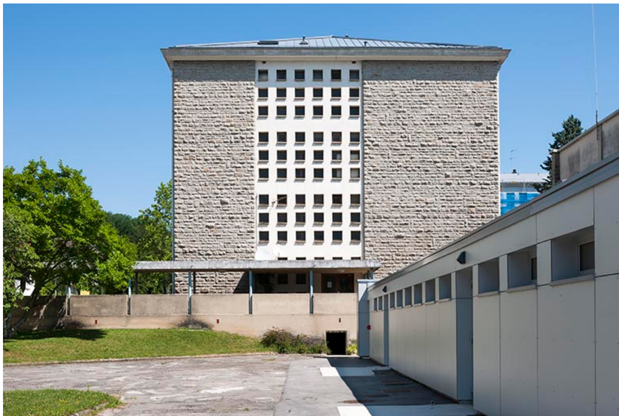
Pignon du bâtiment principal et gymnase.
