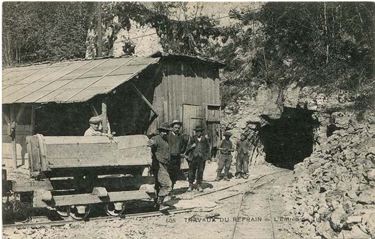
605. Travaux du Refrain - L'entrée du tunnel, vers 1908.
