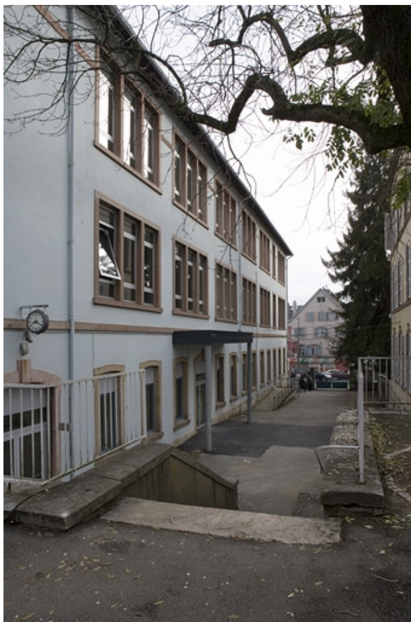
Bâtiment B. Vue face latérale droite.
