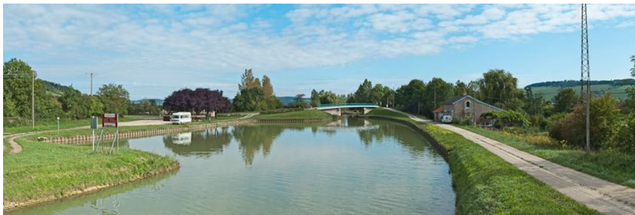
Vue d'ensemble du port.
