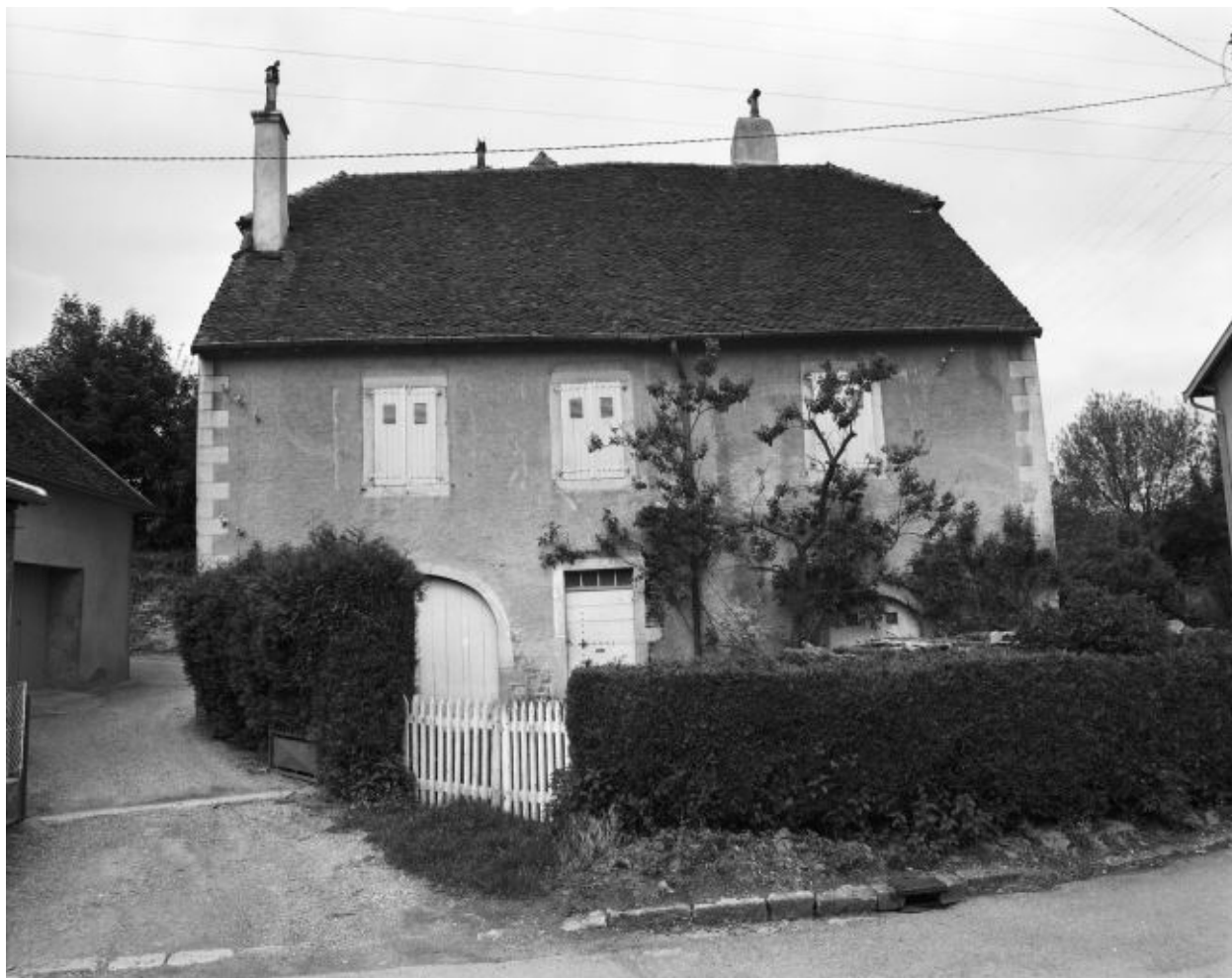
Ferme située rue Saint-Antoine : façade antérieure.
