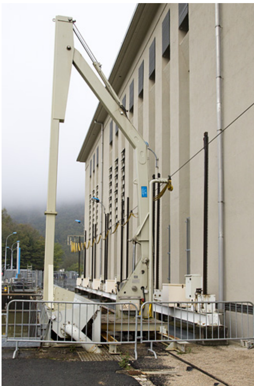
Dégrilleur et façade sud de la centrale.
