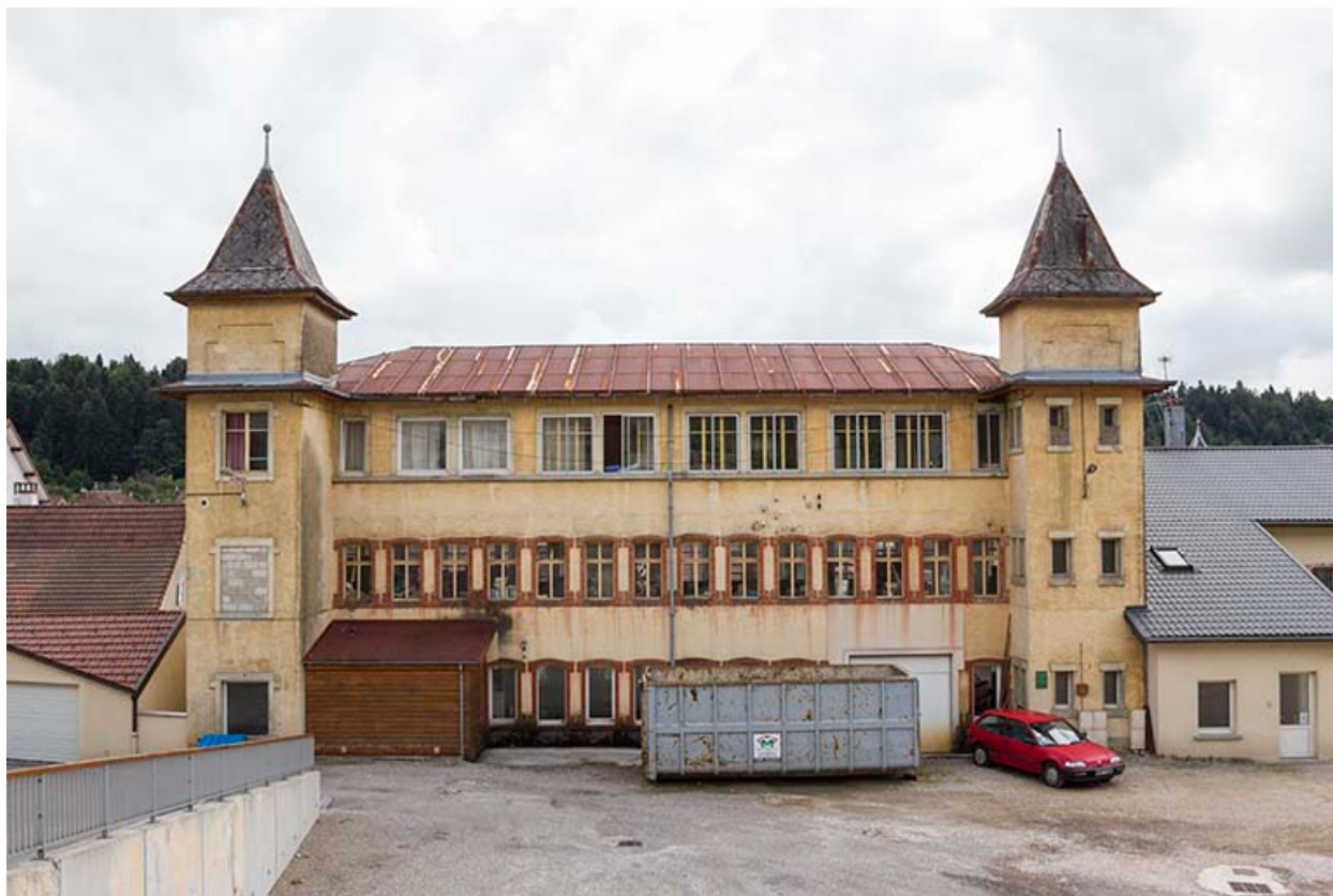
Usine : façade postérieure.
