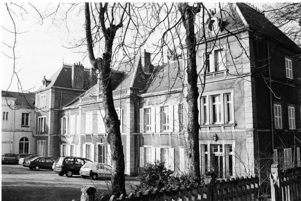
Façade antérieure de la " maison d'administration ".
