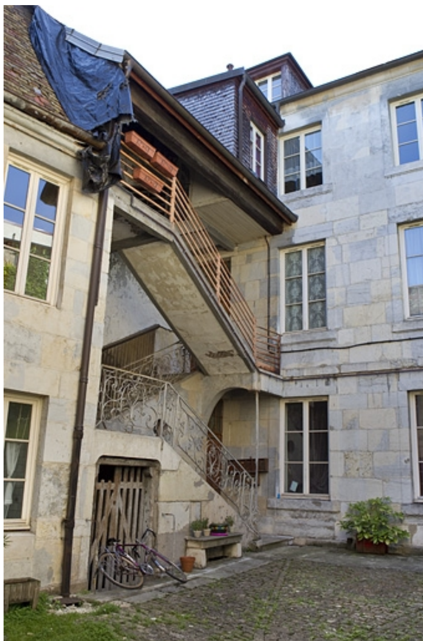
Vue d'ensemble de l'escalier à cage ouverte.
