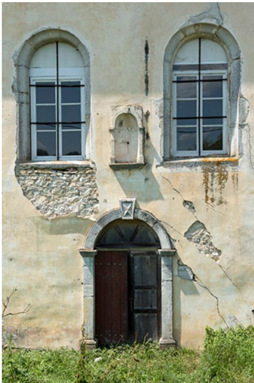
Façade principale de la chapelle
