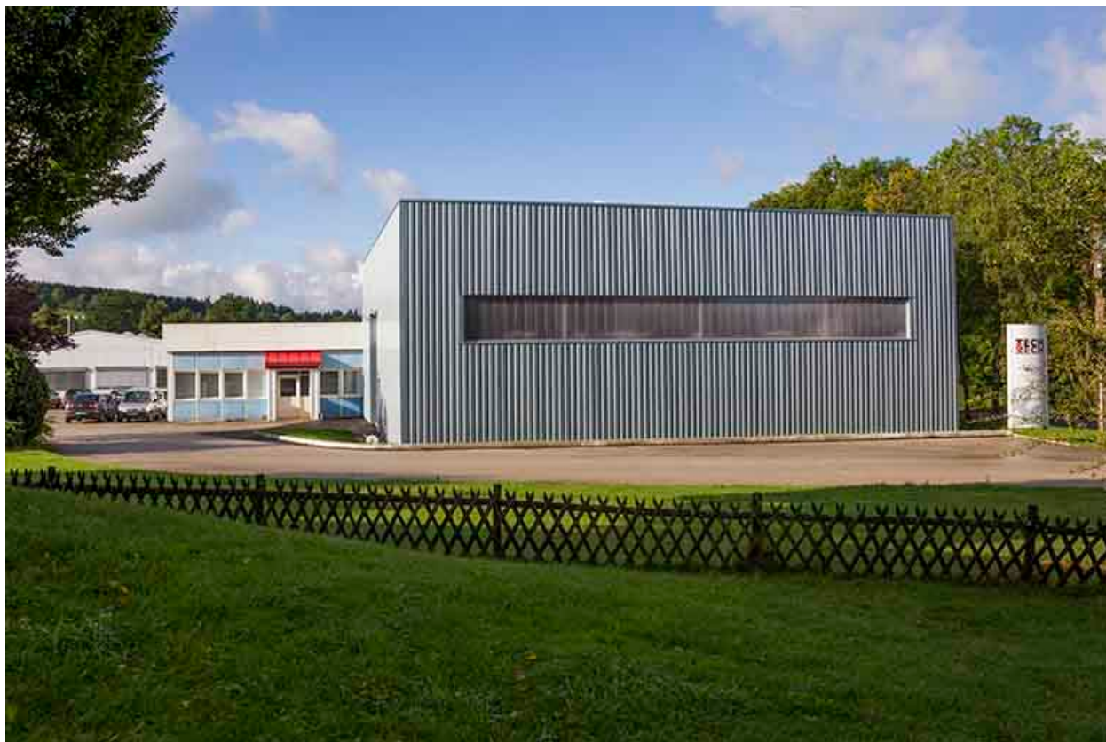
Façade antérieure (atelier de 2013 au premier plan).
