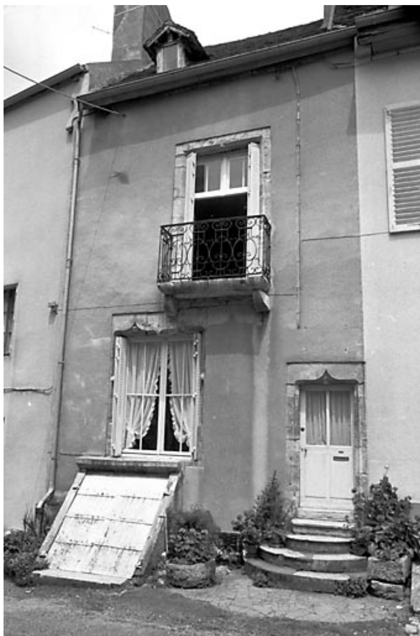
Maison située 6 rue Saint-Hilaire : façade antérieure.
