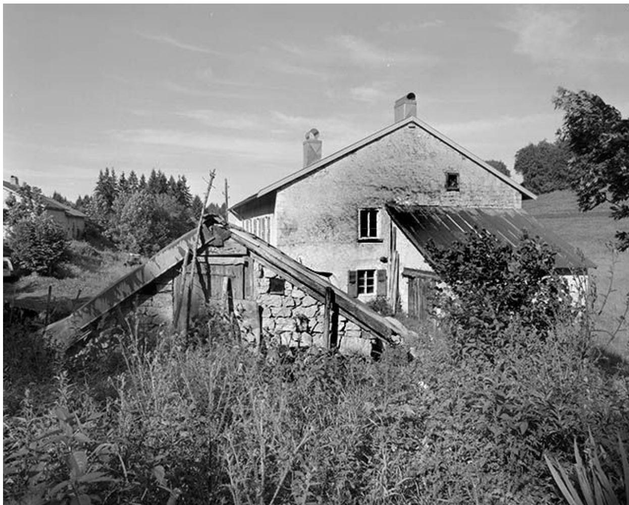
Face droite et remise.
