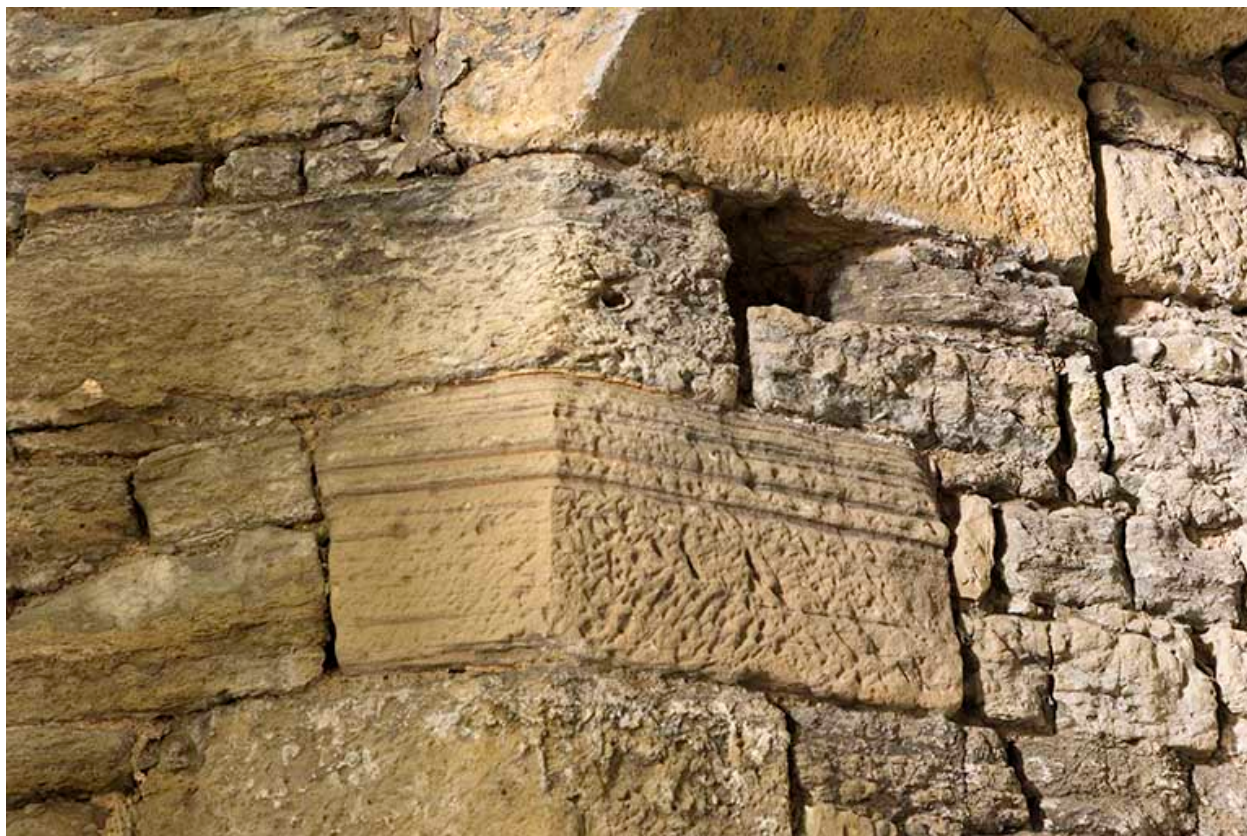
Détail de maçonnerie.
