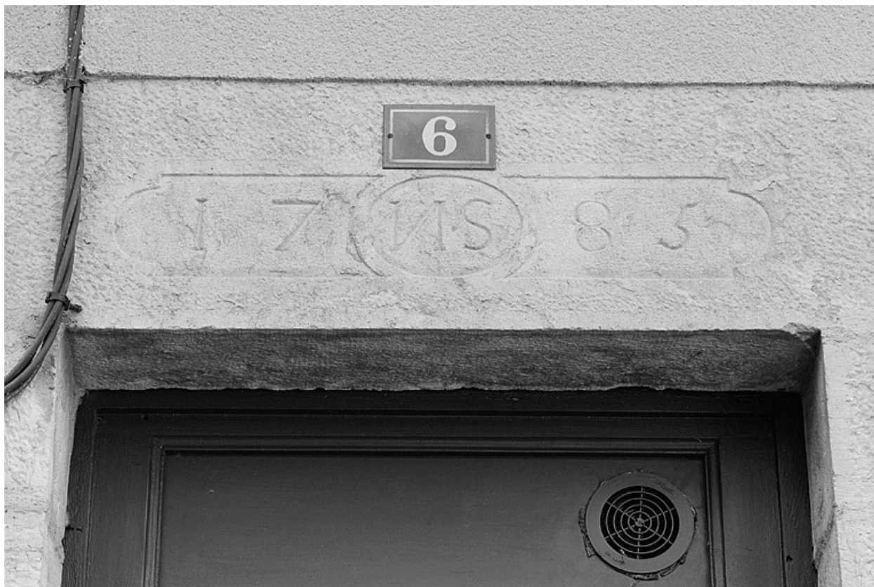
Façade ouest. Détail d'un linteau de porte.
