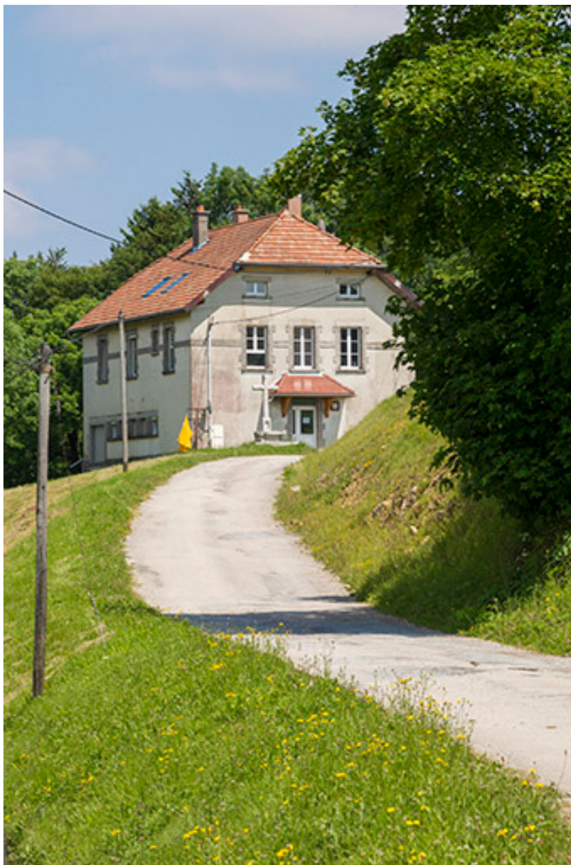
Vue d'ensemble, depuis l'ouest.
