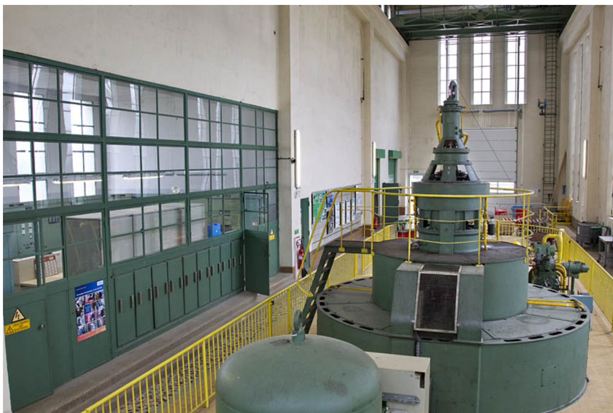
Salle des commandes et groupe turbo-alternateur n°2.
