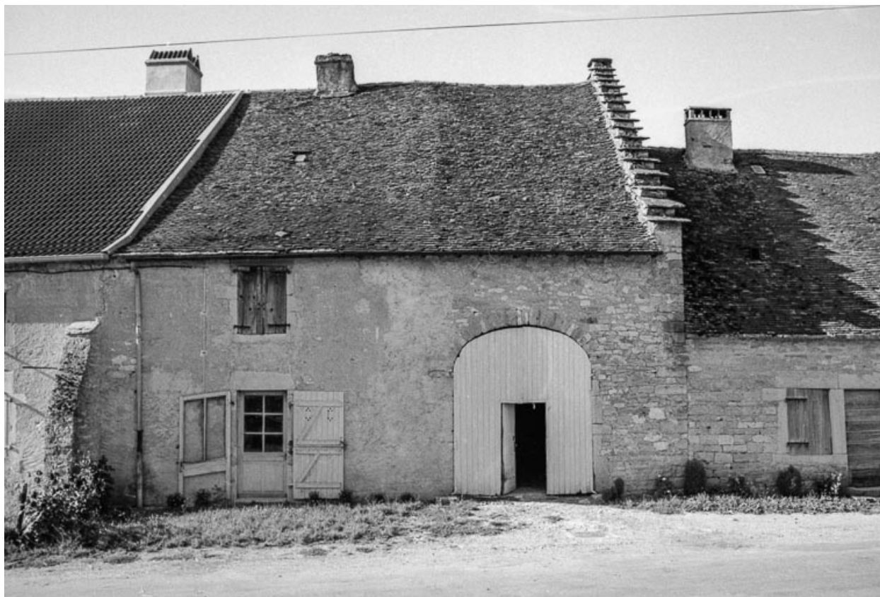
Ferme : façade antérieure.
