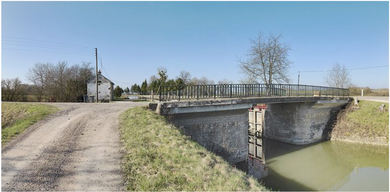
Le pont vu d'aval.
