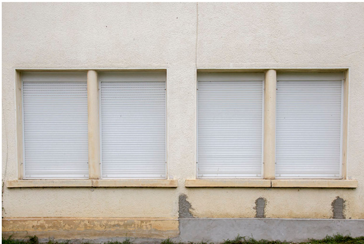
Usine : fenêtres horlogères de la façade antérieure.
