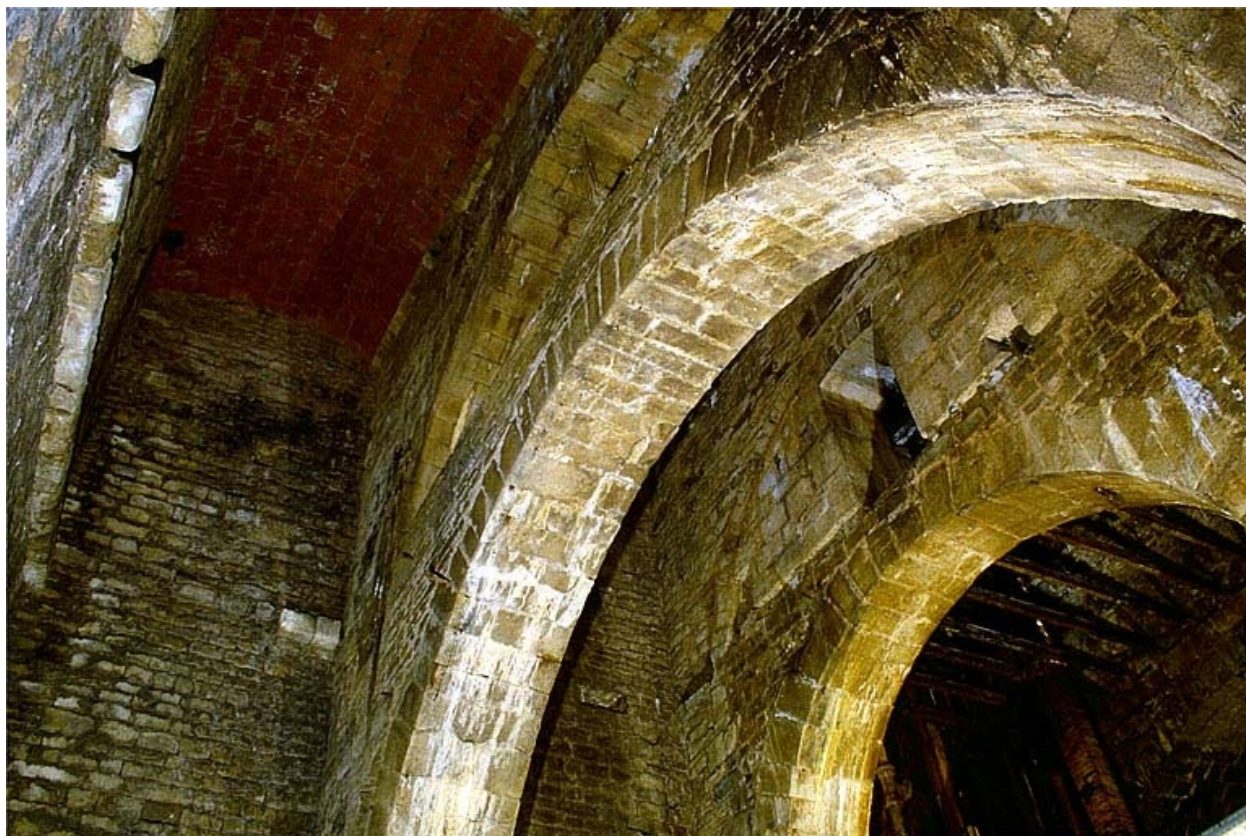
Arcs-diaphragmes et voûtement du puits.
