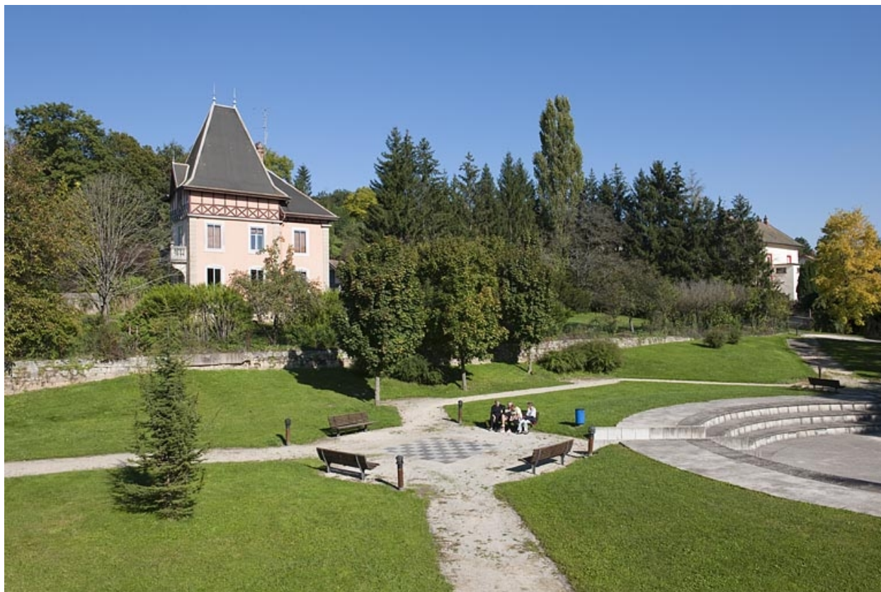
Logement patronal Henri Mégnin. Vue d'ensemble depuis le sud-ouest.
