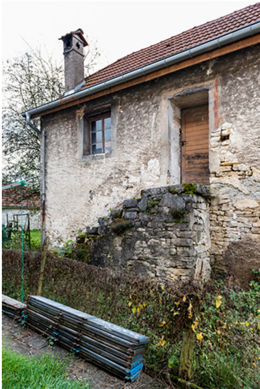
Forge : façade latérale gauche.
