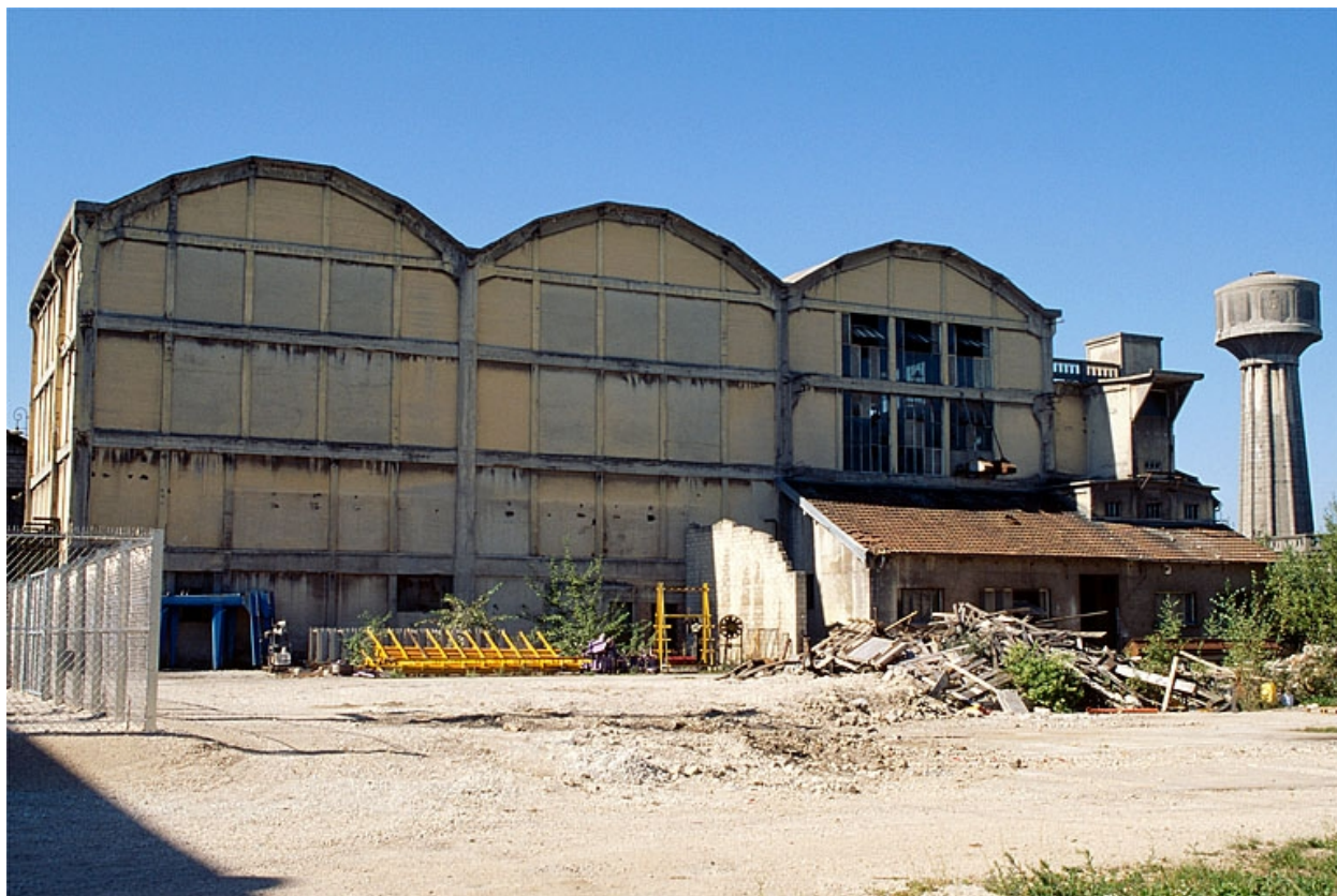
La centrale thermique depuis l'est.
