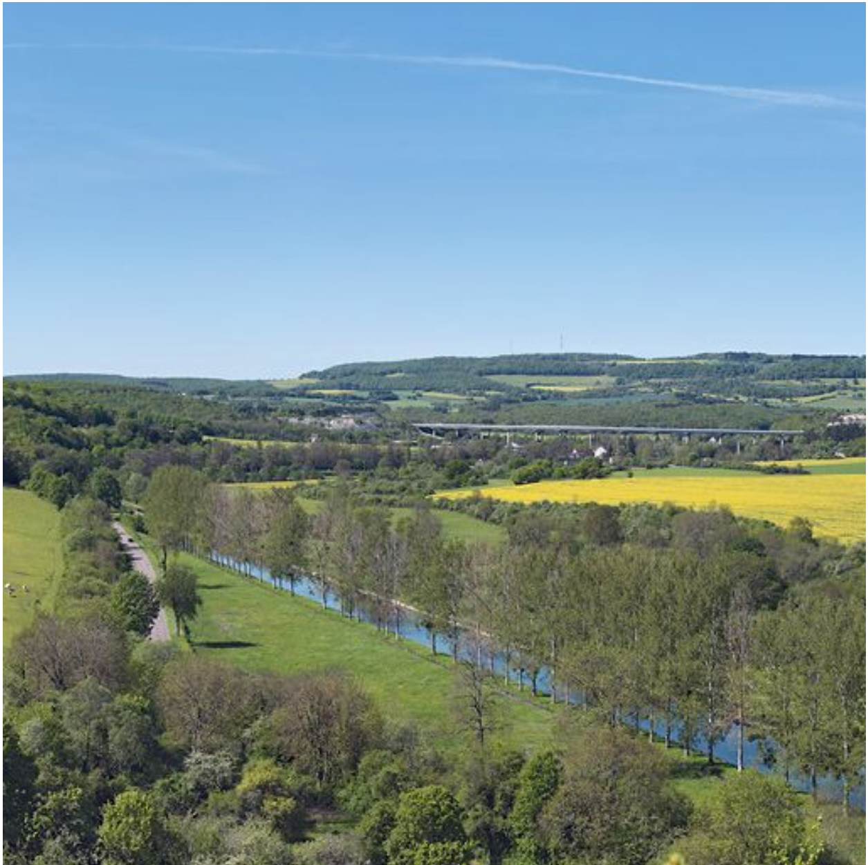
Le viaduc dans son environnement.
