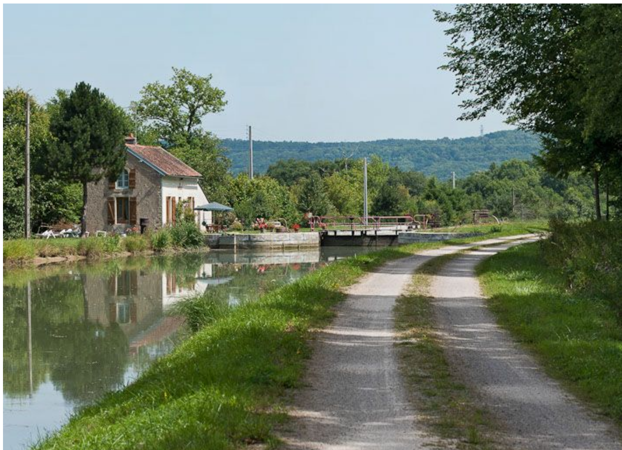
Vue du site d'écluse depuis l'amont.
