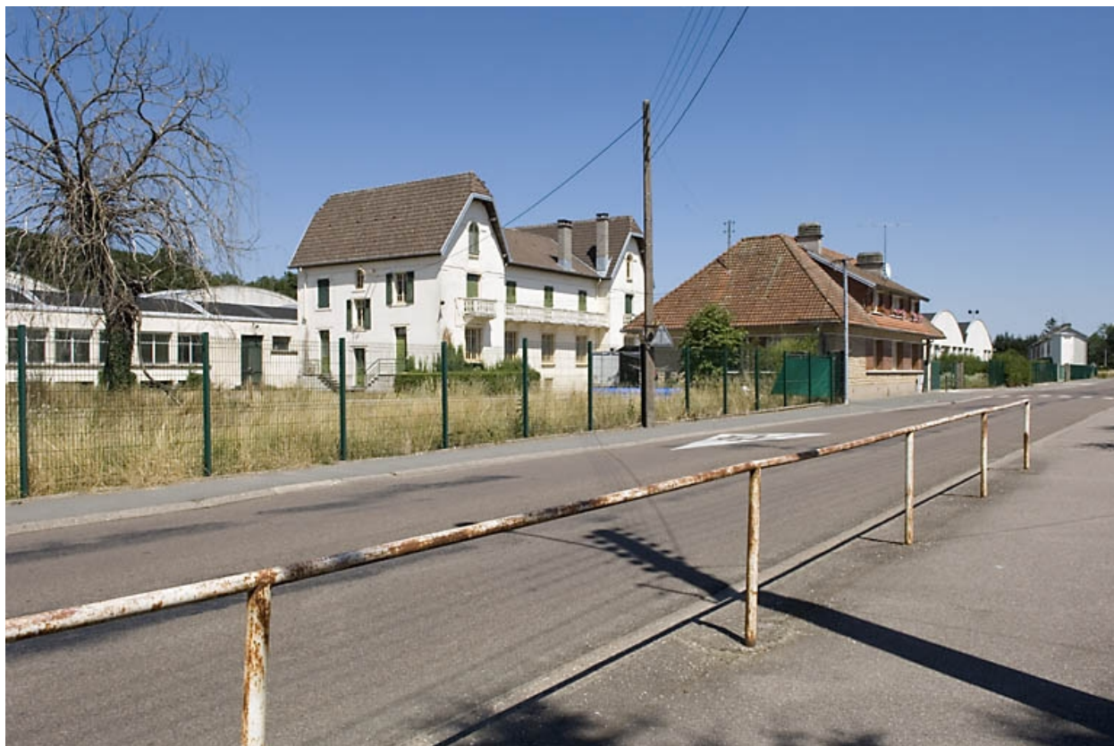
Logements, bureaux et conciergerie depuis l'ouest.
