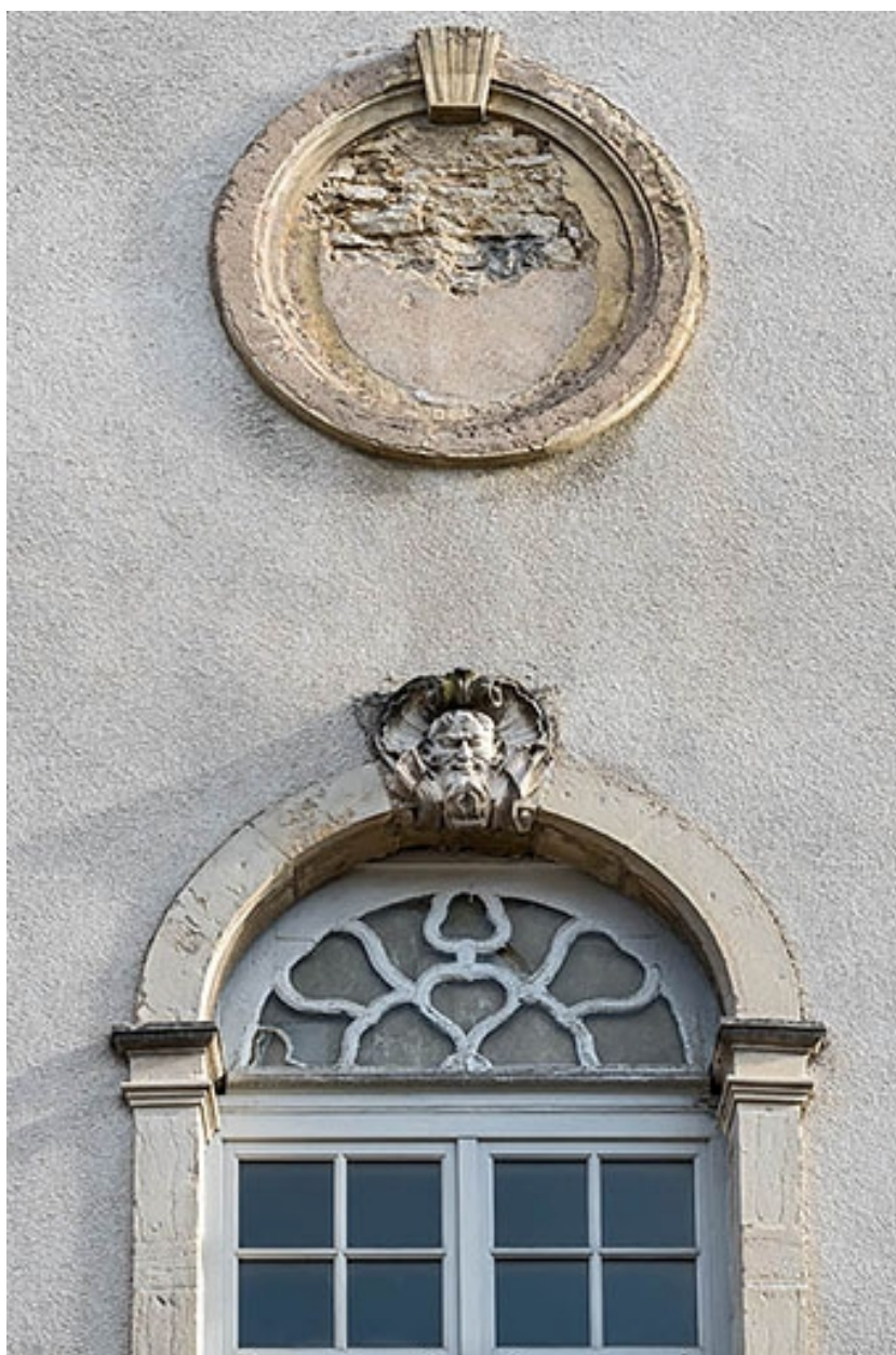
Façade antérieure, travée centrale : baies supérieures.
