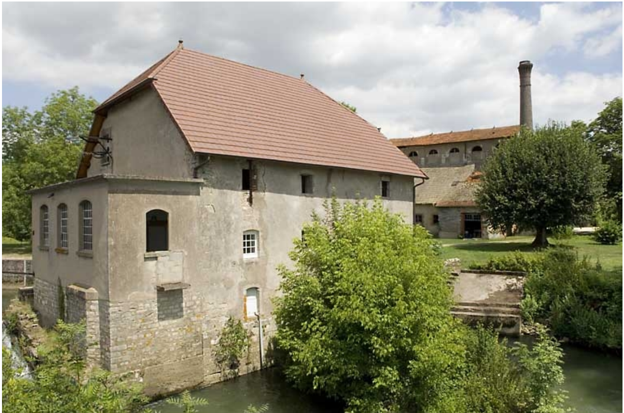
Moulin et haut fourneau depuis le sud-ouest.
