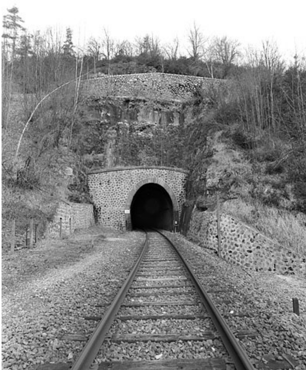
Tunnel : tête côté La Cluse (sud).
