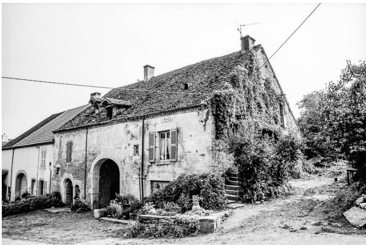
Ferme cadastrée 1964 AC 54 : vue d'ensemble.
