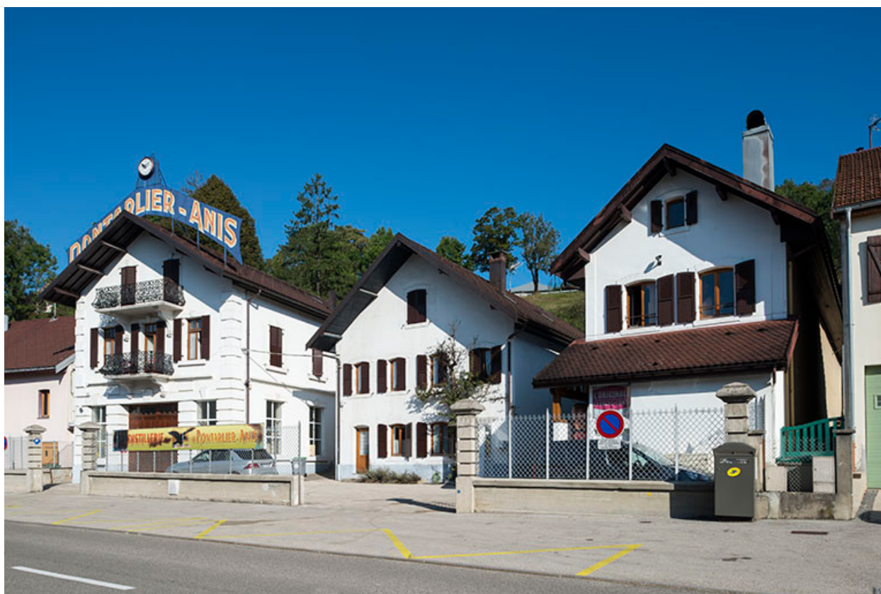
Vue d'ensemble depuis la rue des Lavaux.
