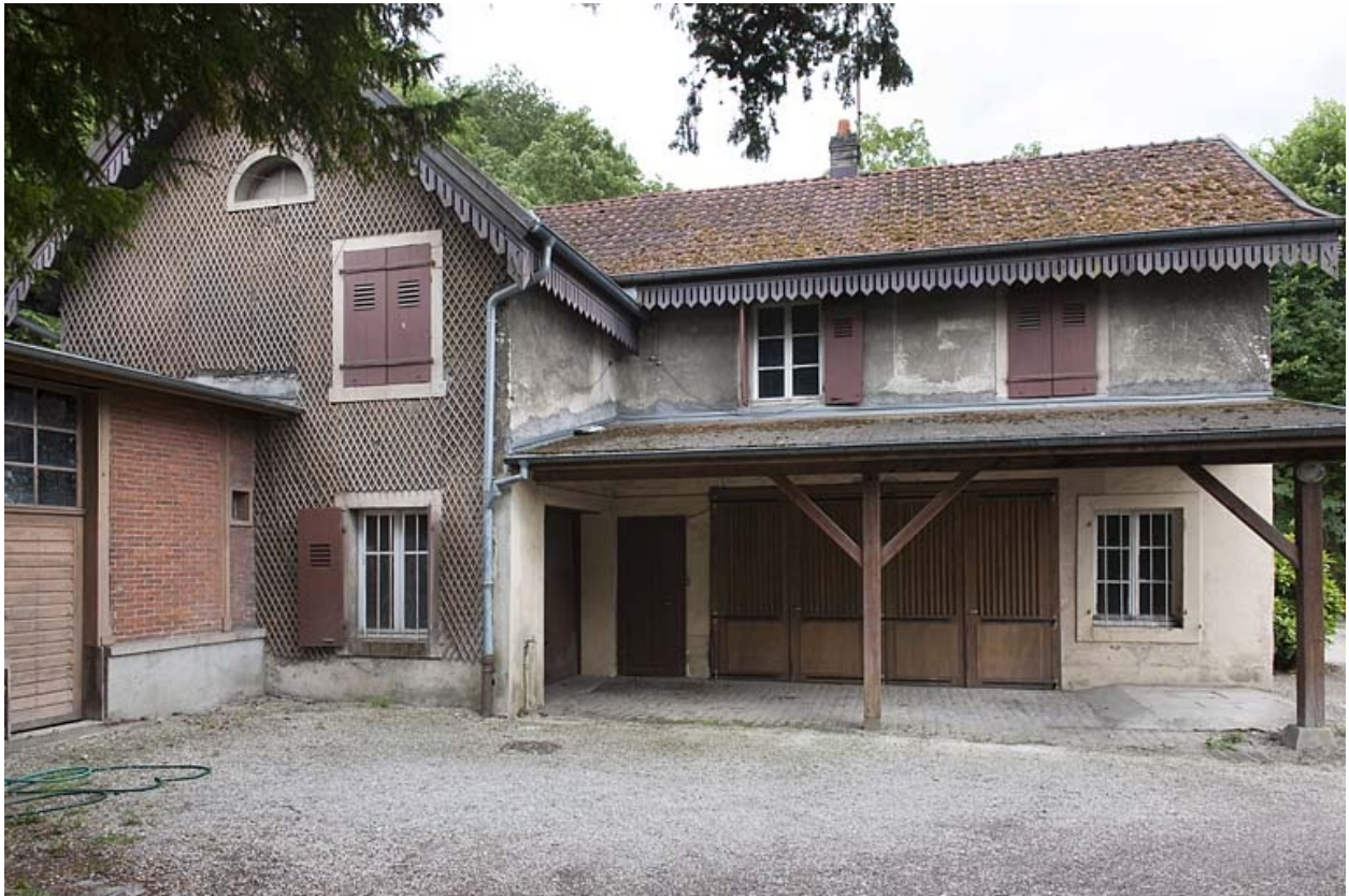
Façade nord des communs.
