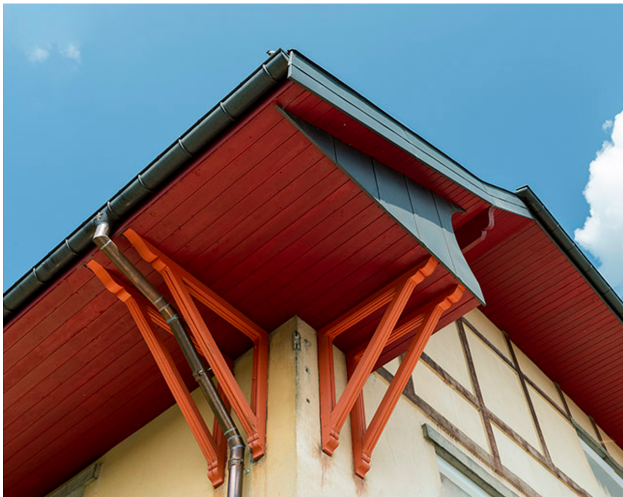
Consoles soutenant l'avant-toit.
