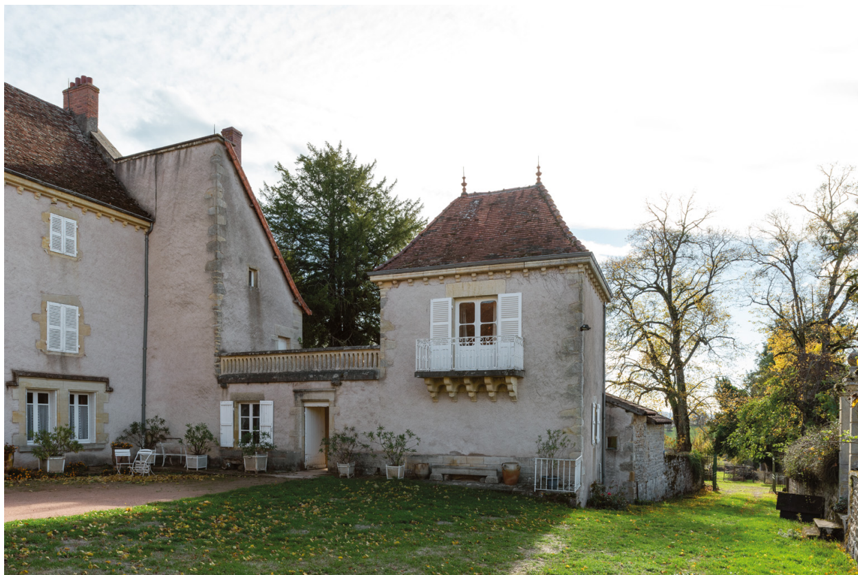
Aile sud du logis et pavillon ouest.
