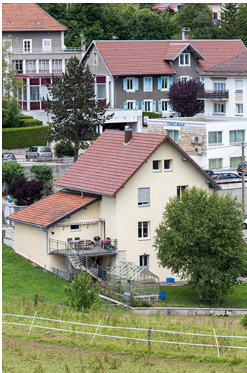
Façades postérieure et latérale droite.
