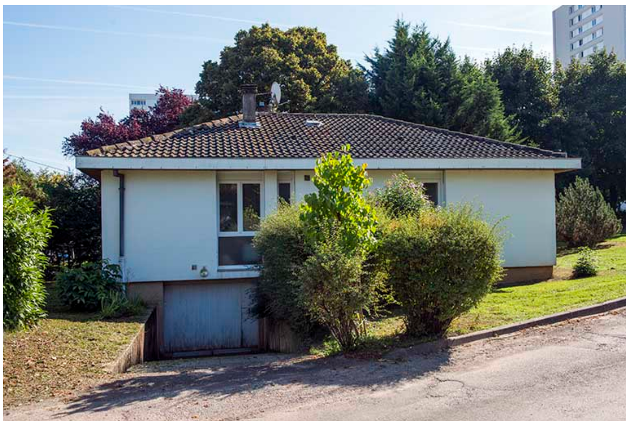
Façade ouest du pavillon logement.
