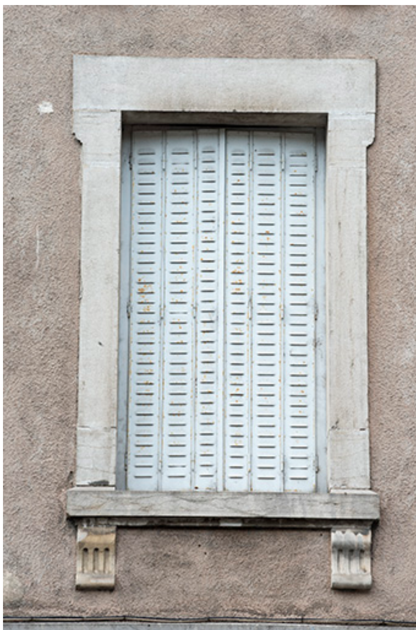
Détail d'une baie, premier étage.
