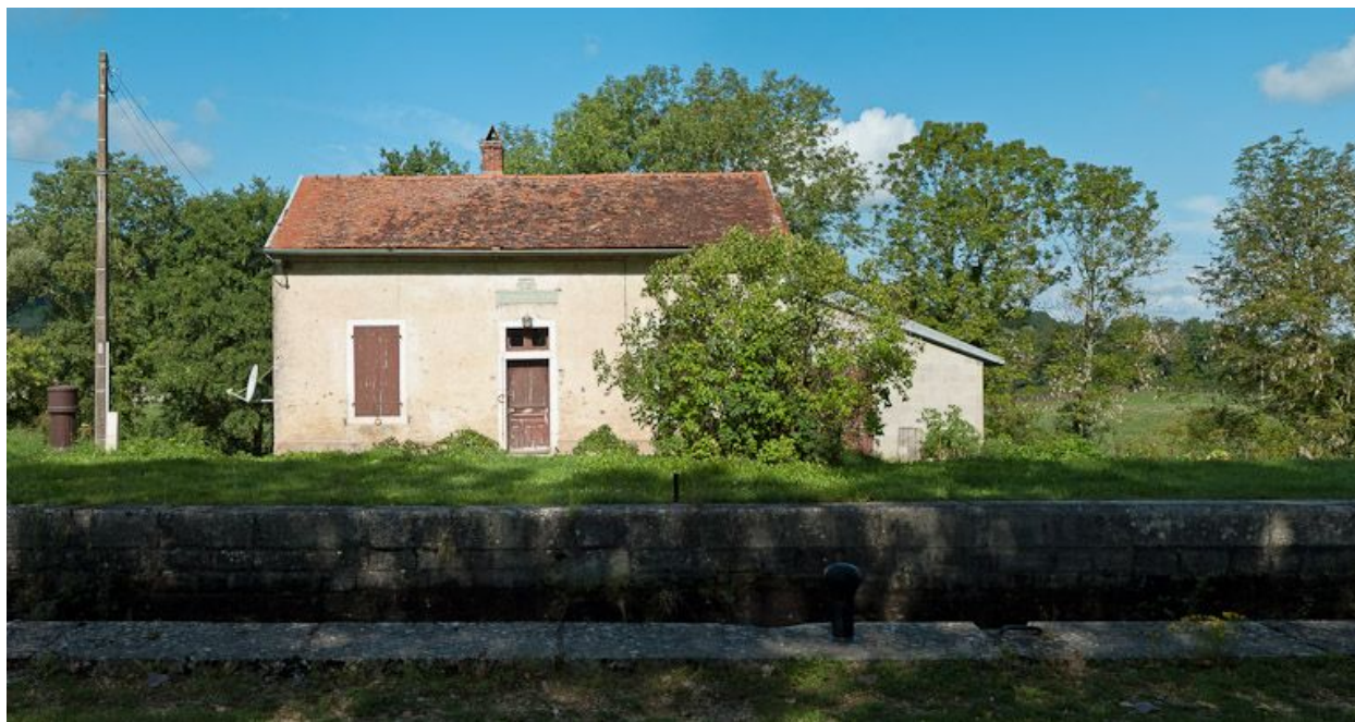
Vue de face de la maison éclusière.
