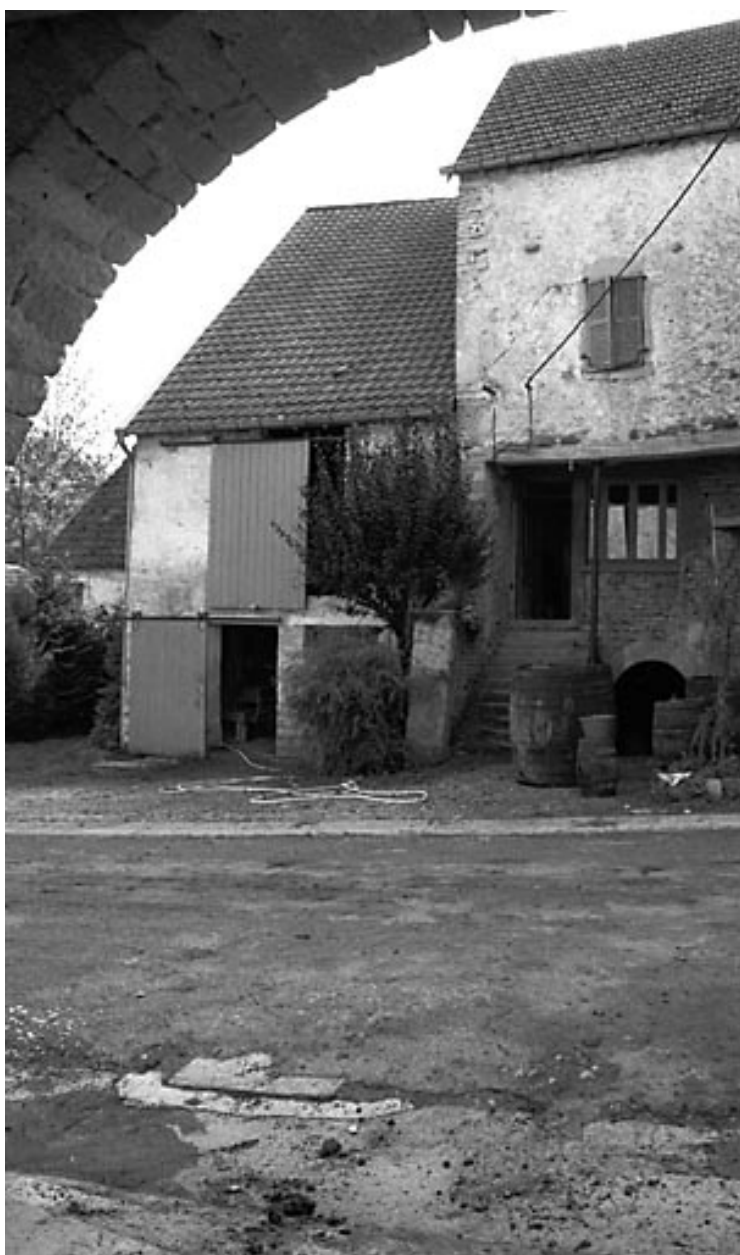
Ferme située rue des Vignottes.
