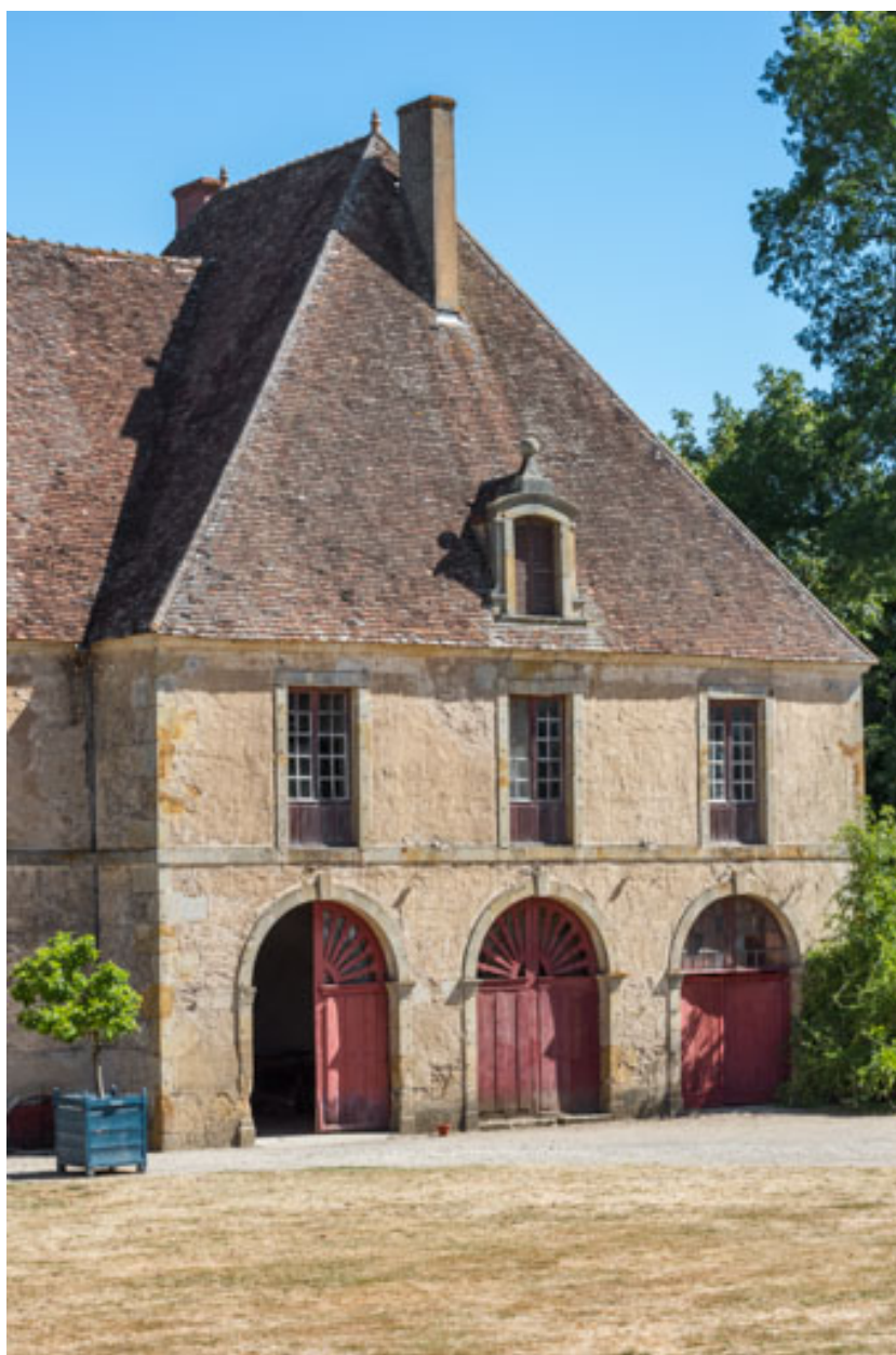
Façade antérieure : pavillon oriental (remises).
