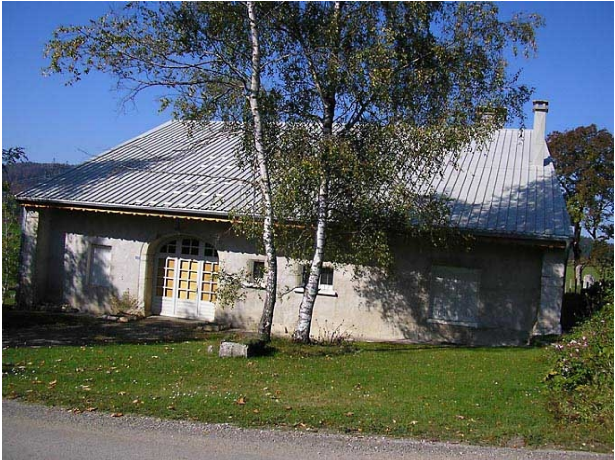
Vue latérale de la façade postérieure.
